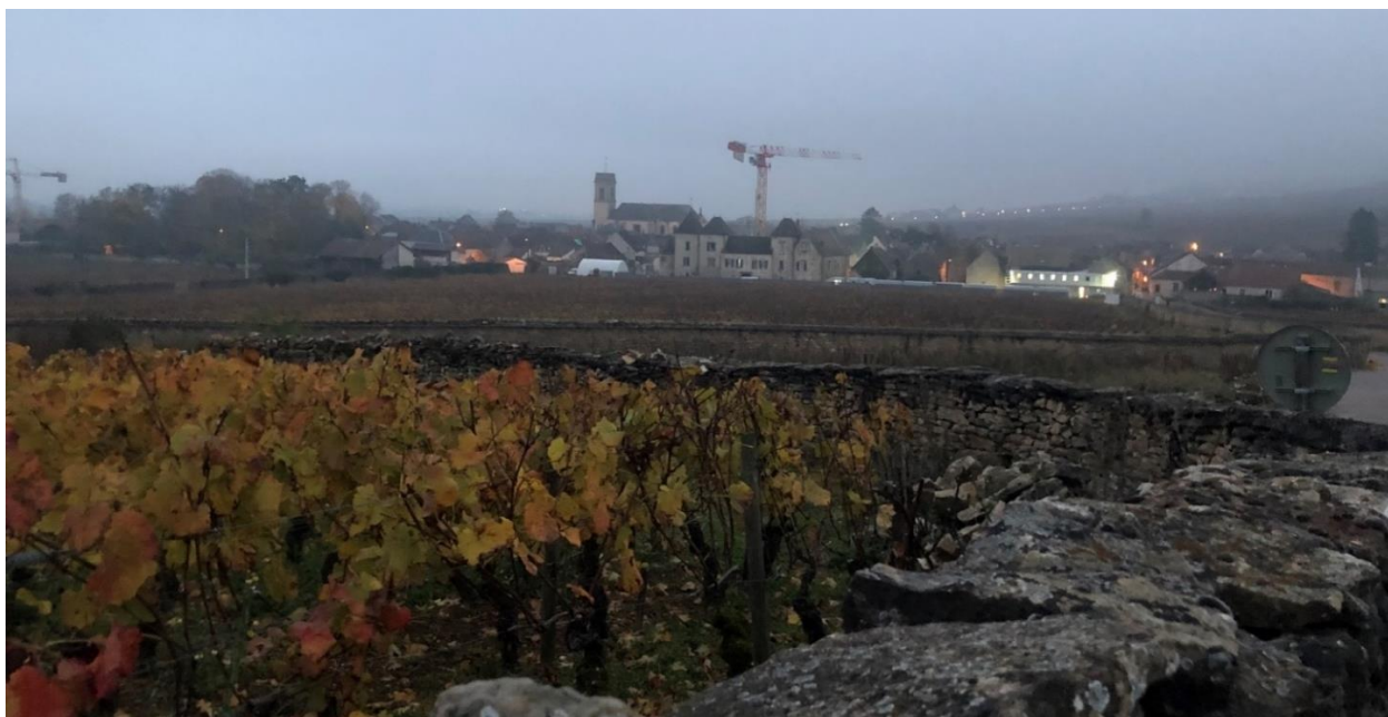
Le Clos Commaraine au crépuscule d'un chantier imposant
